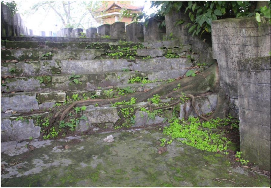
墙垛上生长一颗乔木，乔木以对墙垛造成破 坏，且乔木根系随意生长，已破化地面
