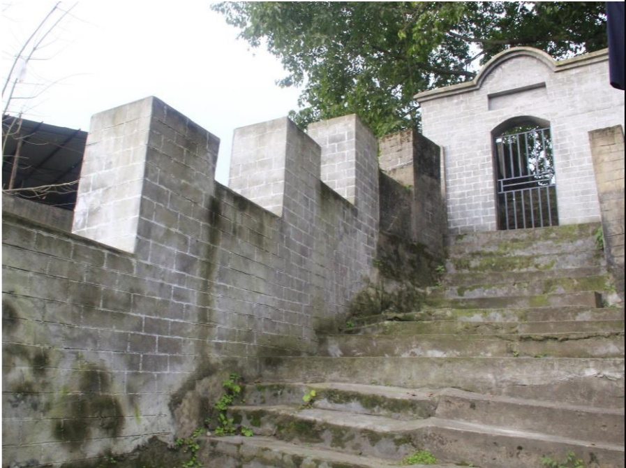
后修复青砖墙垛，有明显色差，初步判断为 水泥砂浆仿青砖做法
