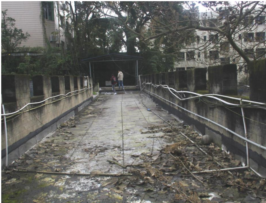
城墙顶垃圾成堆（积水）沥青保温层外露
