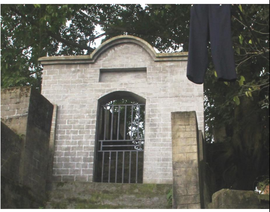
后新建大门，做法为水泥砂浆仿青砖做法，且破坏原有墙垛
