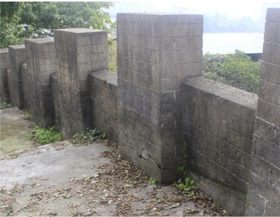
290*160*110 青砖砌筑，面层有风化现象出现，现状不严重，且砖缝及面层长有微生物及杂草
