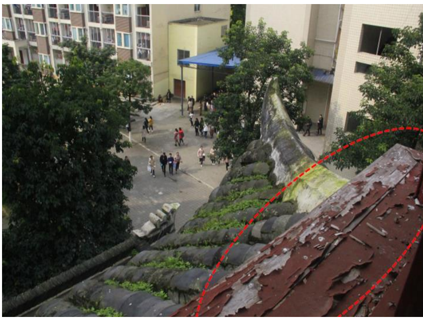
二、三层窗台油漆干裂脱落严重
