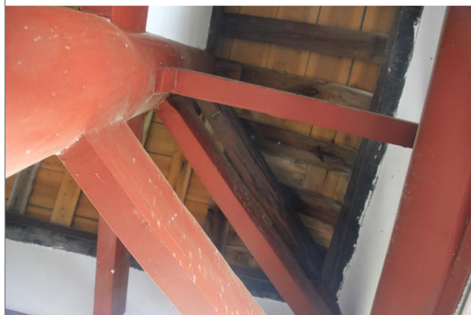
图4-19 部分屋面檩 条有潮湿腐朽现象 (修缮后保留的部分 檩条)
