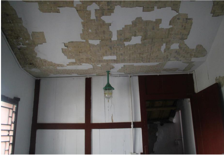
一层阁楼天棚采用不规范的竹压板做天棚基层材料，抹灰层脱落严重（修缮后）
