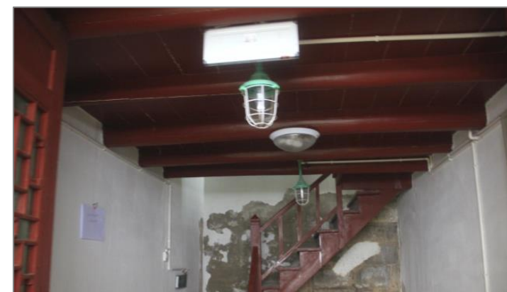
图4-10 一层木楼枋外观结构完好 (修缮后刷红漆)
