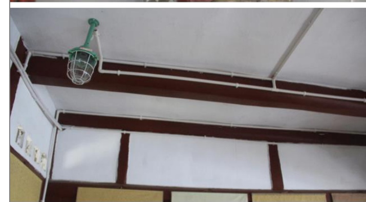
图4-11 二木楼枋外观结构完好 (修缮后刷白浆)
