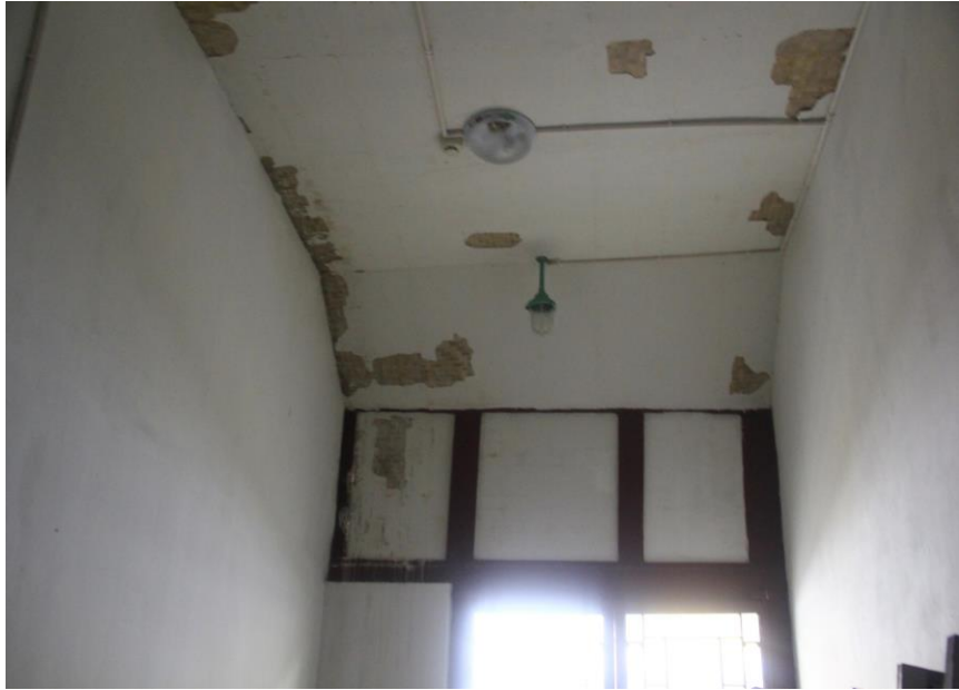
一层左侧房间室内墙面与屋顶受潮白浆脱落严重
