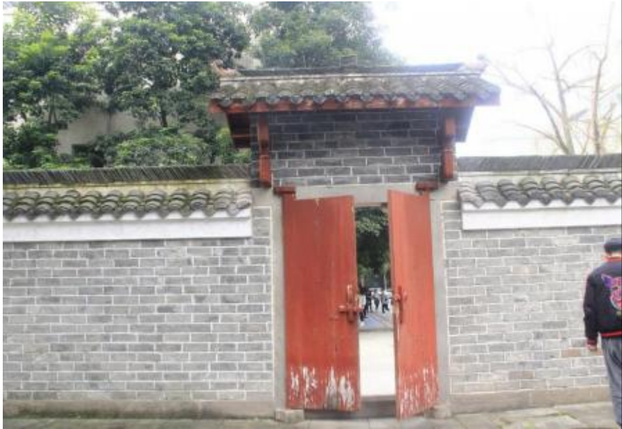
2-10 侧院入口院门背立面（修缮后）
