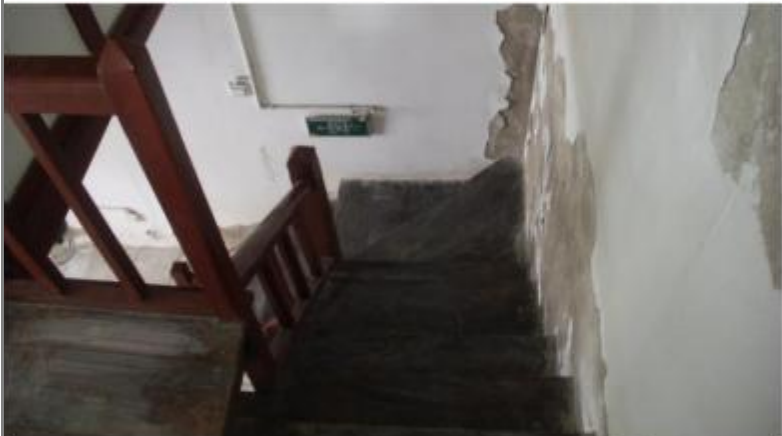
图4-13 一层上 阁楼层木楼梯 (L型楼梯)
