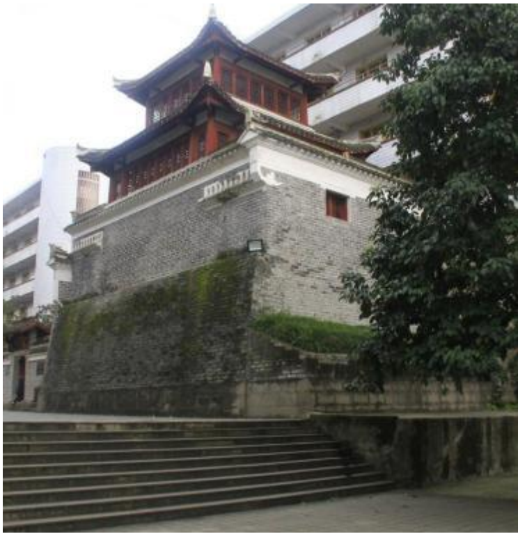
西侧下沉广场看诏书阁视角
