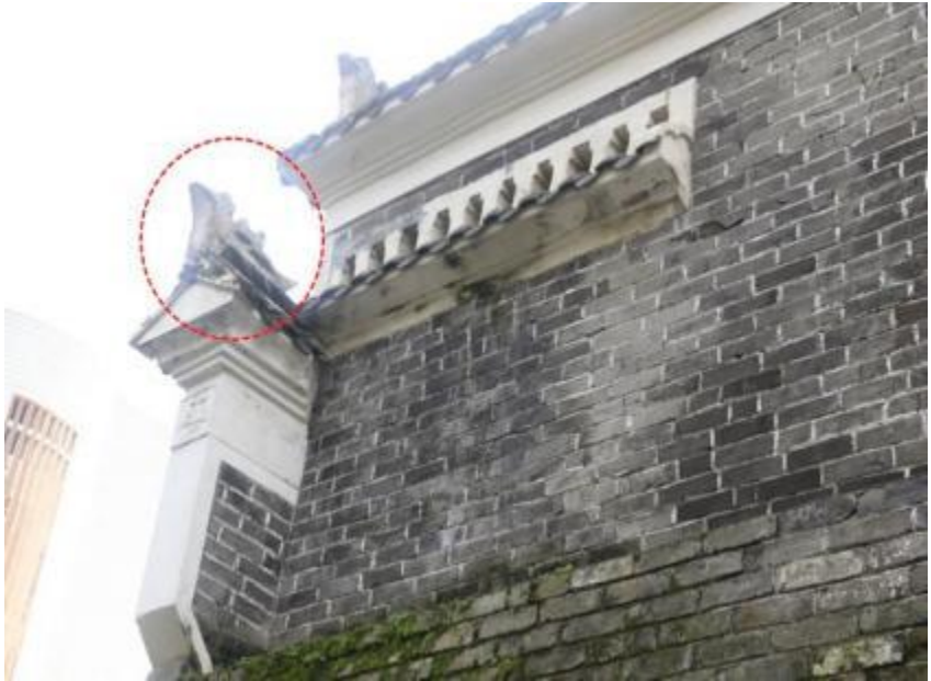
2-6 山墙顶脊兽造型装饰（修缮后增加）
