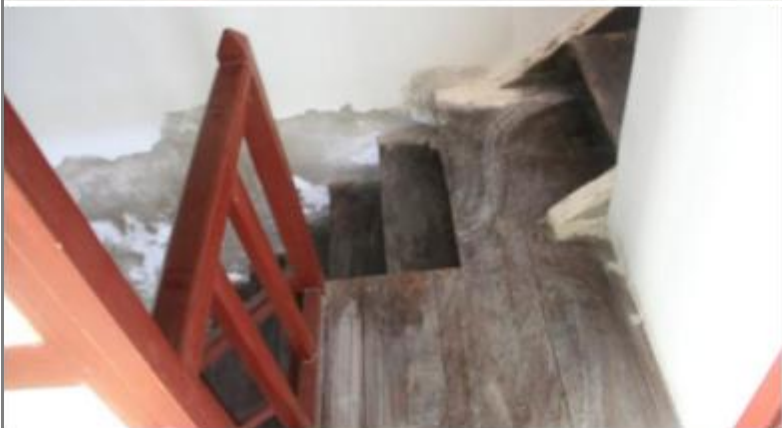
图4-14 阁楼层木平台
