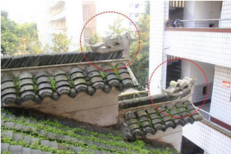
山墙顶脊兽造型装饰（修缮后增加）
