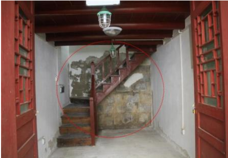
一层右侧房间室内墙面受潮白浆脱落严重
