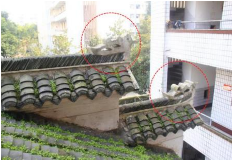
2-4 山墙顶脊兽造型装饰（修缮后增加）
