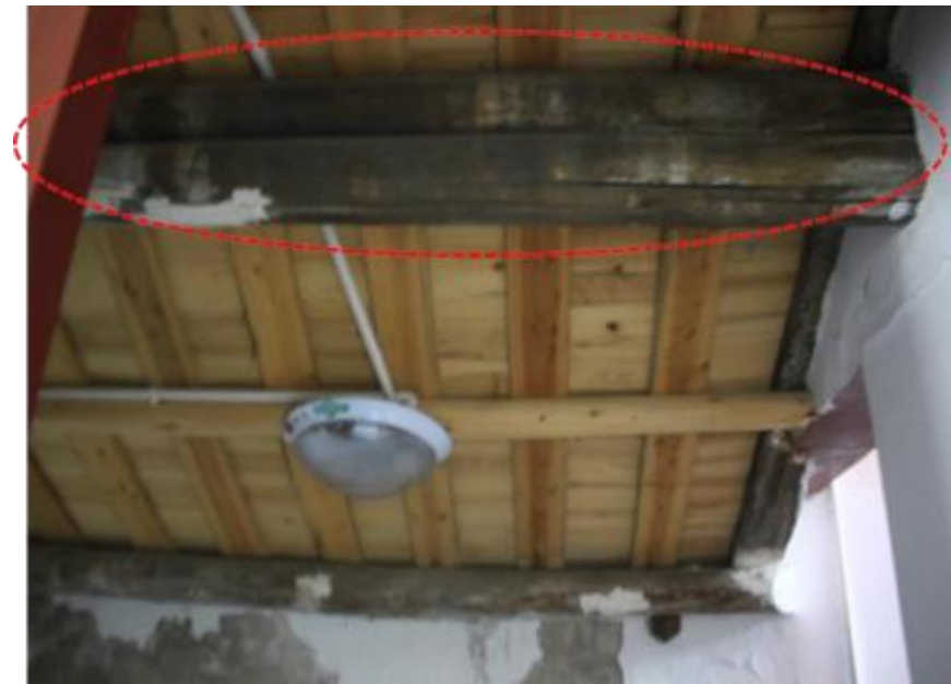
阁楼层坡屋面横梁受潮变腐，墙面白浆脱落
