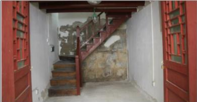
图4-12 一层上 阁楼层木楼梯 (L型楼梯)
