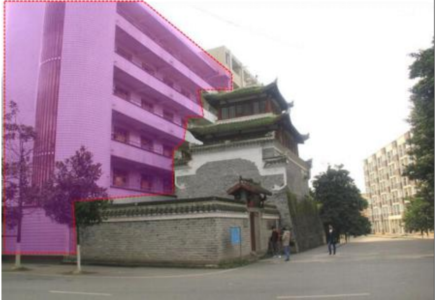
1-6 阁楼后方建筑——现为男宿舍楼
