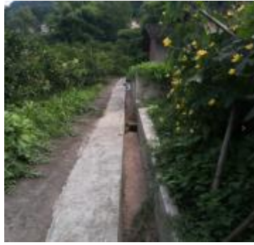
图二：硬化灌溉水道
