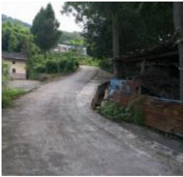
图四：硬化通村便民道路
