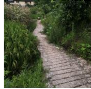
图六：硬化生产便道
