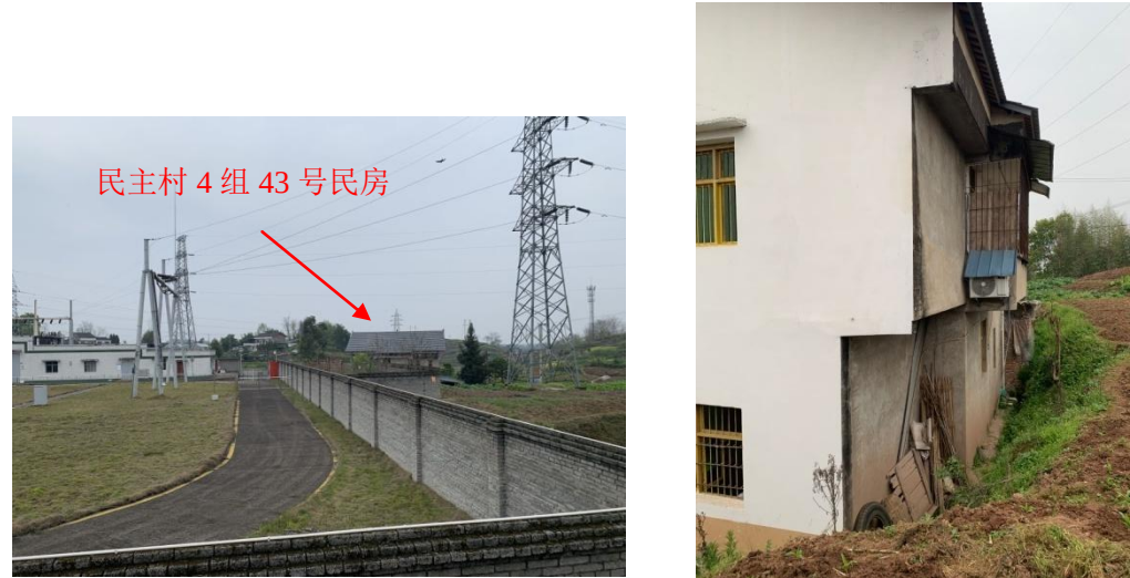
图 4-4 民房与高峰变电站位置关系 图 4-5 民房与变电站高差关系
