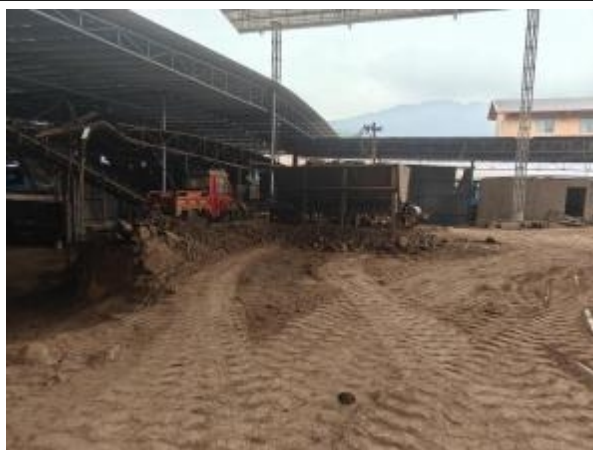
页岩原料堆场未设置三面围挡
