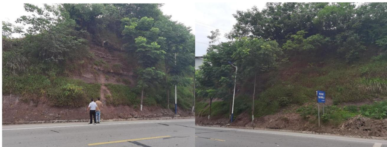
该段边坡岩质部分为砂岩为主，岩体中发育两组裂隙，现用赤平投影对岩质边坡进行稳定性分析：
