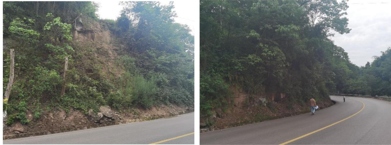
该段边坡岩质部分主要为砂岩，岩体中发育两组裂隙，现用赤平投影对左右两侧岩质边坡进行稳定性分析：
