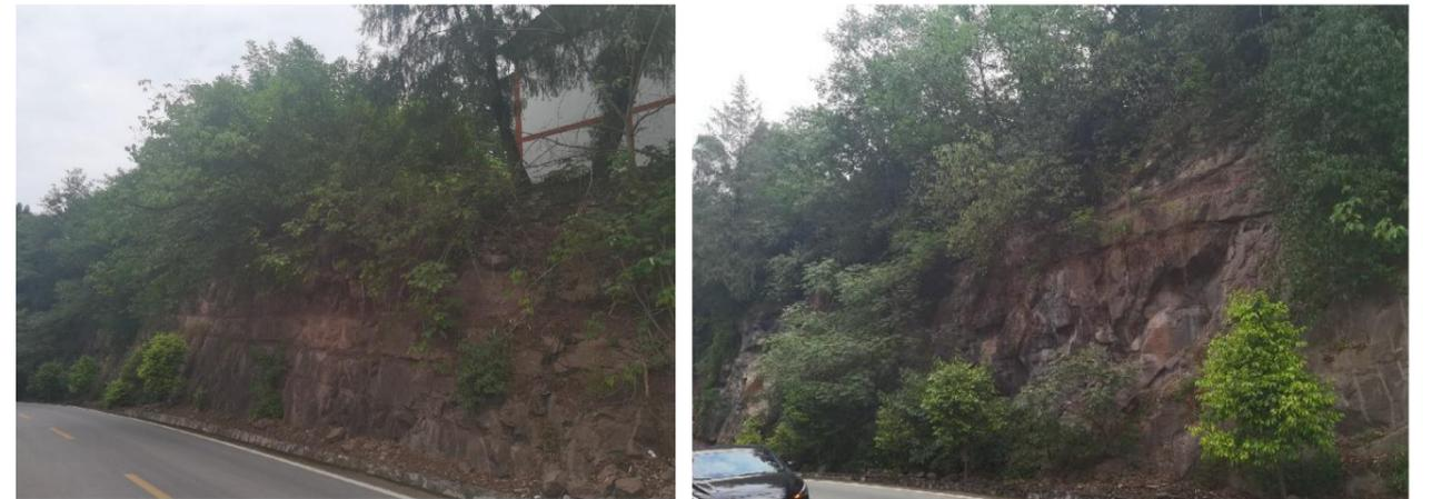
该段边坡岩质部分以砂岩为主，岩体中发育两组裂隙，现用赤平投影对岩质边坡进行稳定性分析：
