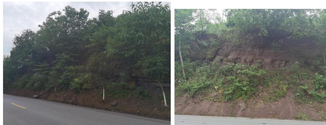
该段边坡岩质部分为泥岩为主，岩体中发育两组裂隙，现用赤平投影对岩质边坡进行稳定性分析：
