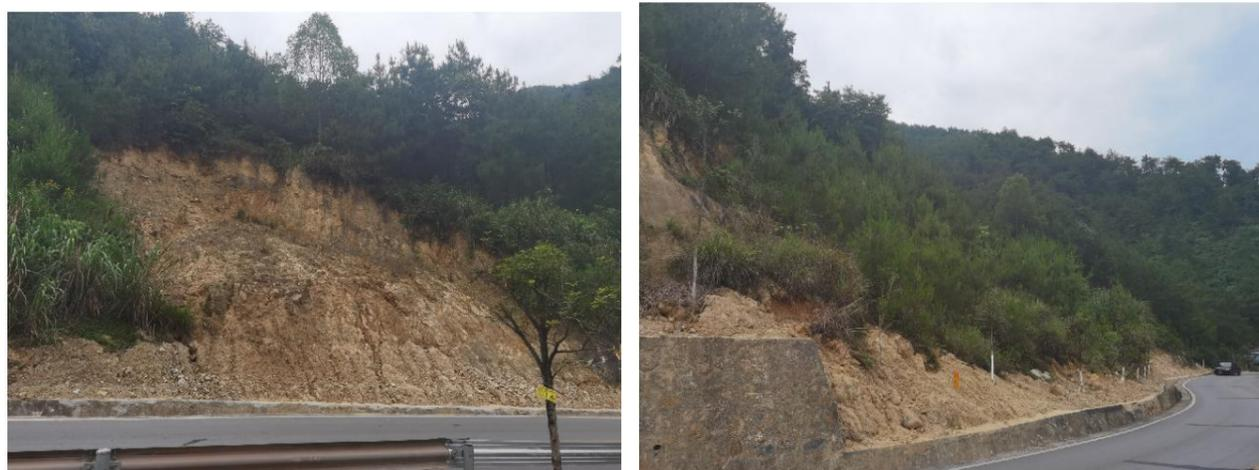
处治方案：清除塌方后进行 1:1.25 放坡，并在坡脚处设置 4m 高路堑墙。对损坏边沟进行修复。
