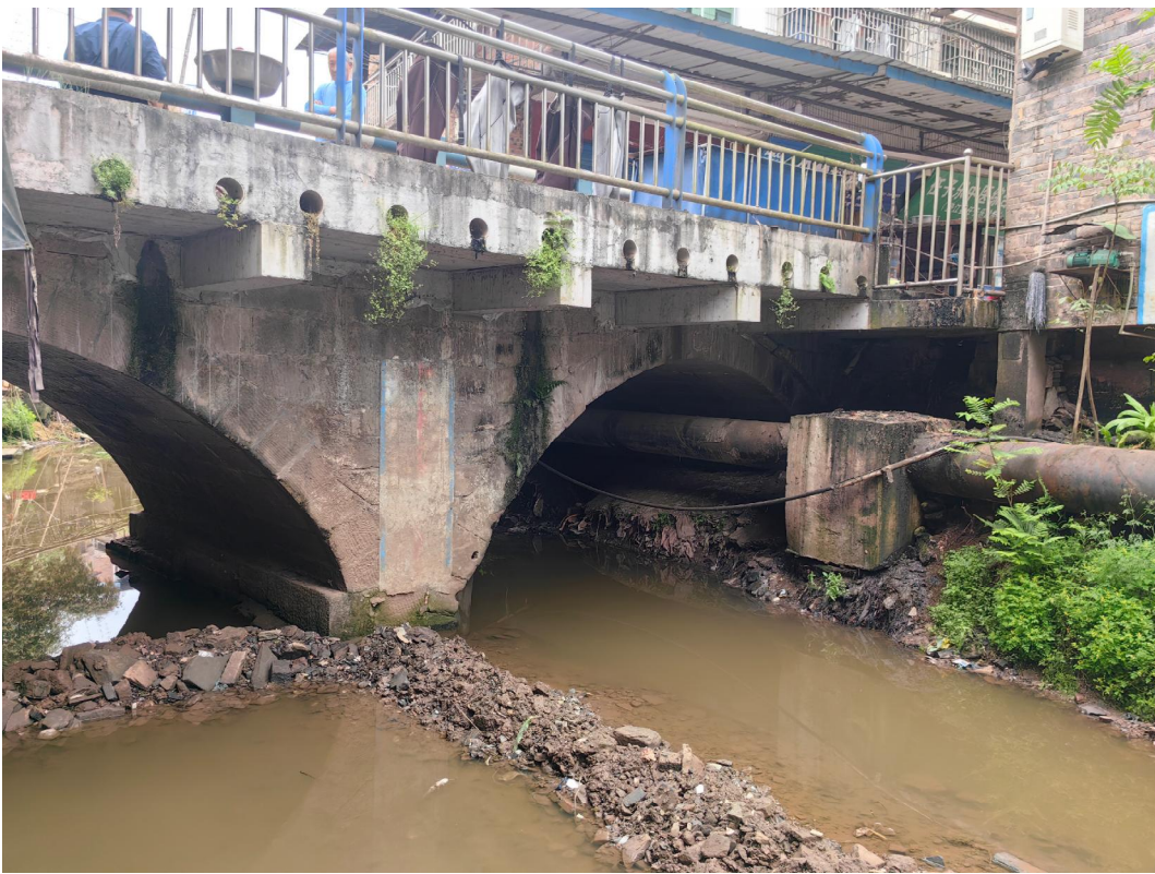
既有桥梁现场照片
